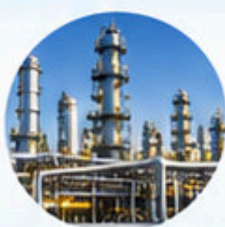
Monitoraggio di coperture pressostatiche in ambito industriale
